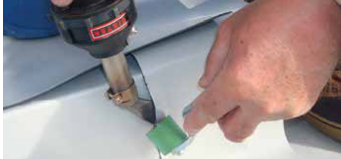
HOT JET S con ugello angolare durante la saldatura di un giunto a T sul tetto.
