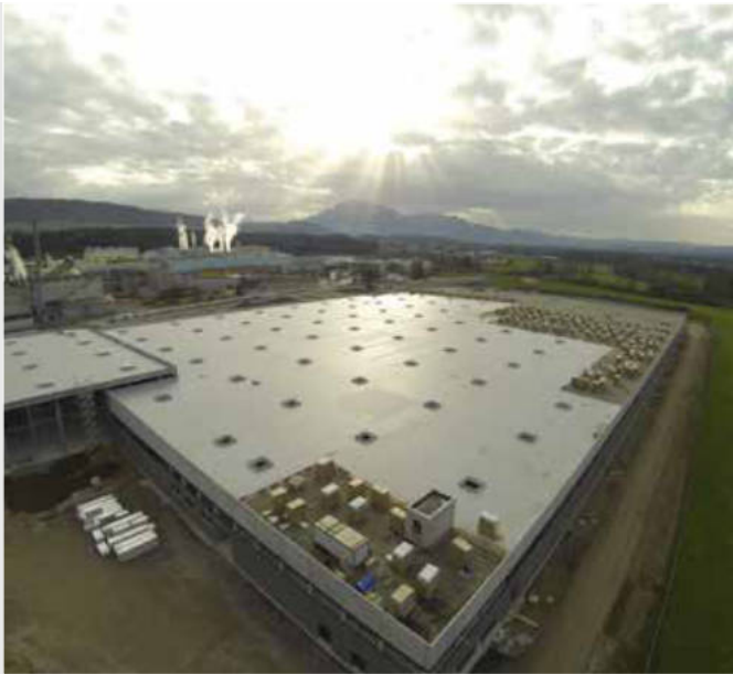
Aldi centro logistico 50000m2 TPO membrana, Svizzera
