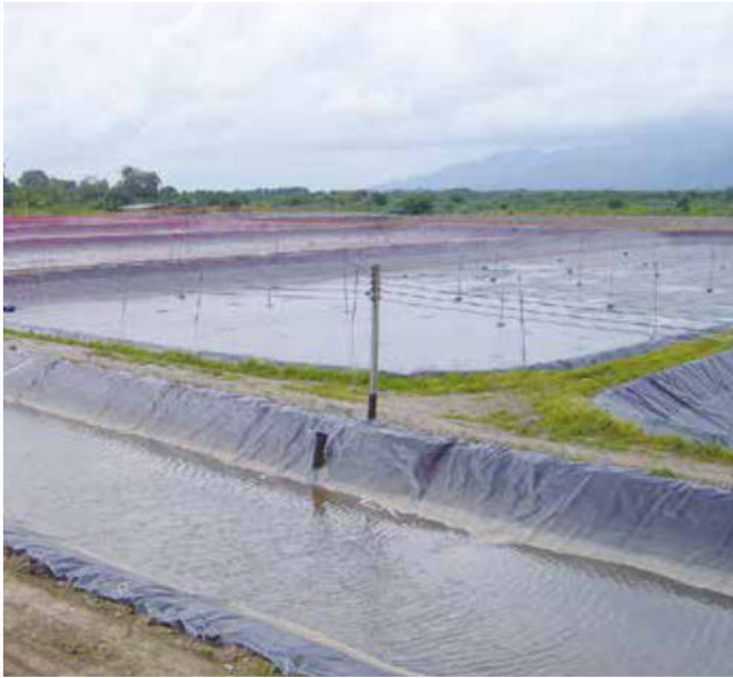
Impianto di piscicoltura HDPE 0.5 mm
