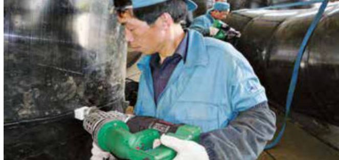
Applicazioni di FUSION2 nella costruzione di serbatoi.
