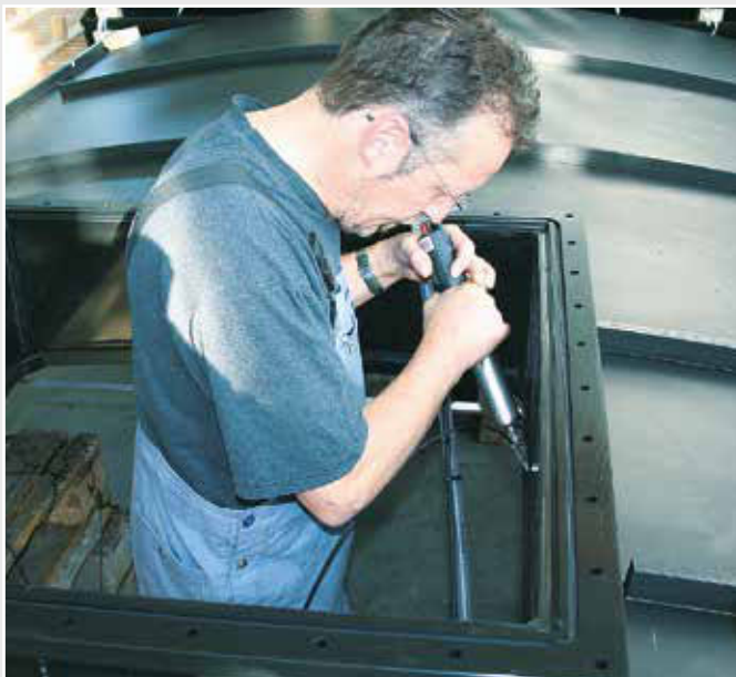
DIODE S utilizzato nella saldatura a trascinamento nei dettagli del serbatoio.
