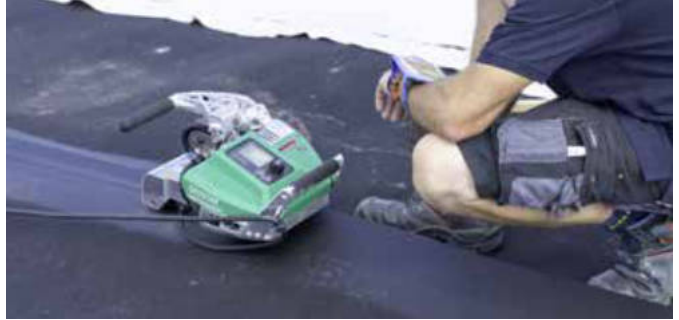
GEOSTARLQS impiegato sul campo.
