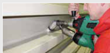
La testina angolare a 45° di WELDPLAST S2 semplifica le operazioni di saldatura nelle posizioni più complesse (accessori).
