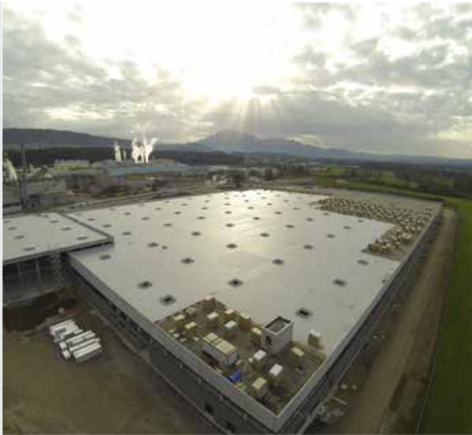
Aldi centro logistico 50000m2 TPO membrana, Svizzera
