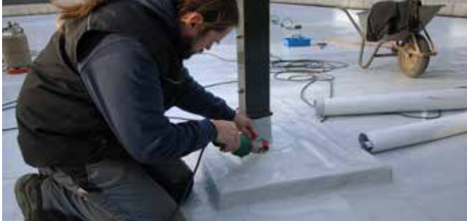
Saldatrice manuale con guaine di impermeabilizzazione in plastica.
