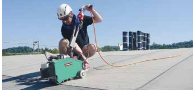
BITUMAT B2 effettua la saldatura senza fiamma di guaine bituminose.
