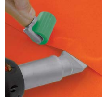
Fabrication de bâches : rouleau de 40 mm
