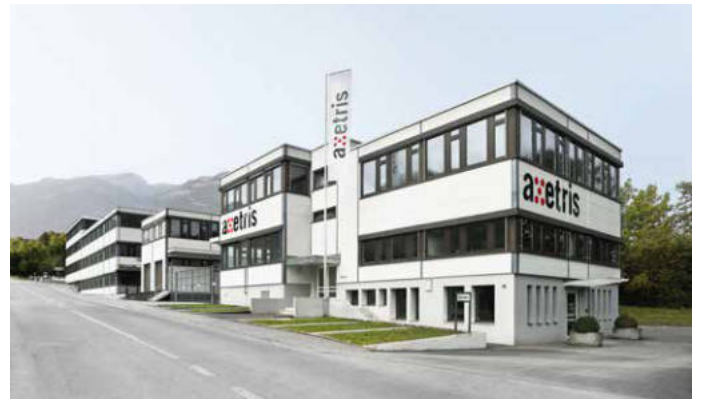
Leister Technologies AG, Production, Kaegiswil, Suisse
