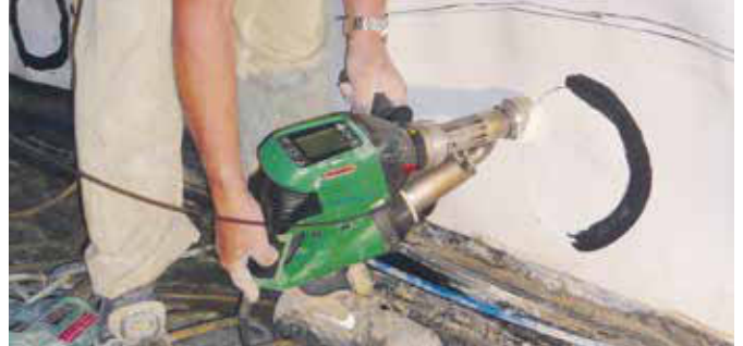
La robuste WELDPLAST S2 lors du soudage d'une « retouche » dans la construction d'un tunnel.
