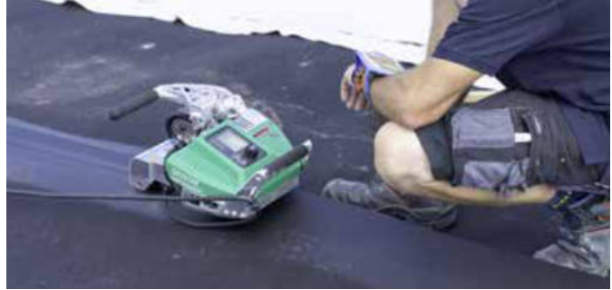
GEOSTARLQS en utilisation sur le terrain.
