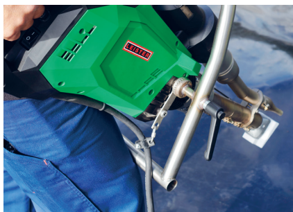
Passage vertical des câbles
